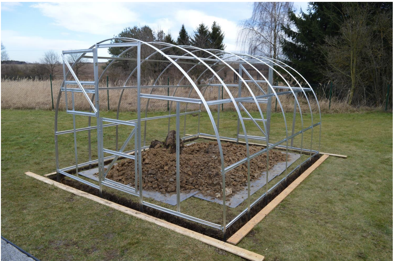
Ilustrativní obrázek ukotvení konstrukce do země
